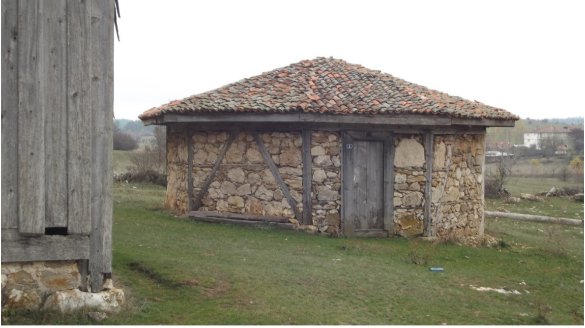
Resim 5.) Ömersin Köyü Divan Camii Batı Cephesinde Kümbet Tarzı Yapı
